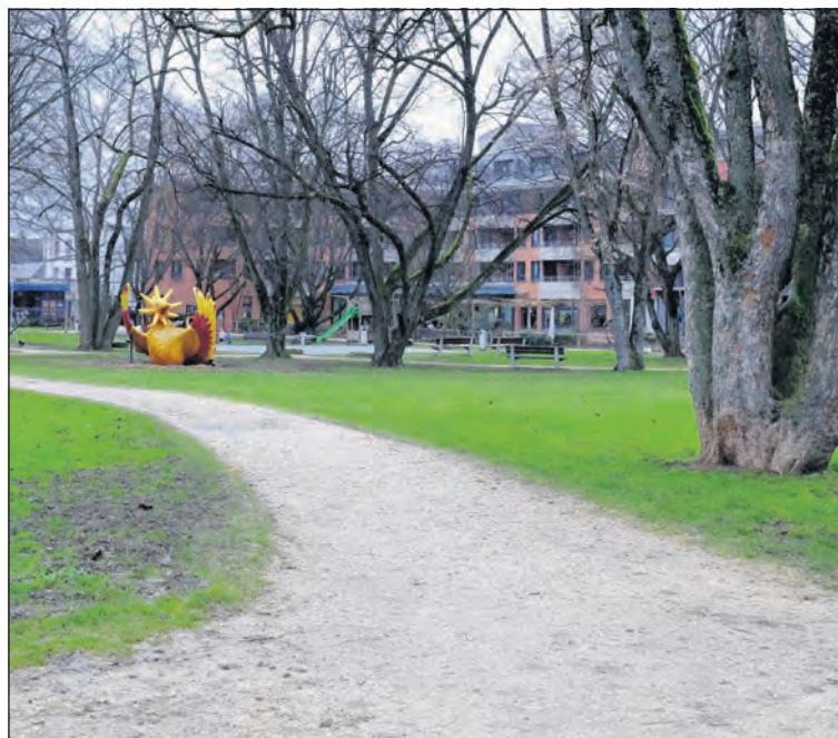
Stein des Anstosses waren die Gehwege im Joeripark, die mit Rollatoren und Rollstühlen schwer passierbar sind.
