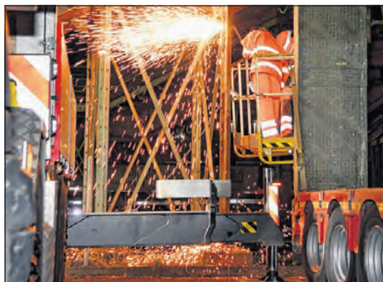
Die Stahlkonstruktion wurde in Teile geschnitten und Stück für Stück abgetragen. Seit 1913 führte die Überquerung über die Gleise. Der Baubeginn des Ersatzbaus soll im kommenden Jahr liegen, da sonst 1,2 Millionen Franken vom Bund aus dem Agglomerationsprogramm wegfallen.
