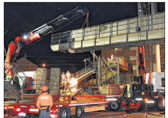
Die Stahlkonstruktion wurde in Teile geschnitten und Stück für Stück abgetragen. Seit 1913 führte die Überquerung über die Gleise. Der Baubeginn des Ersatzbaus soll im kommenden Jahr liegen, da sonst 1,2 Millionen Franken vom Bund aus dem Agglomerationsprogramm wegfallen.
