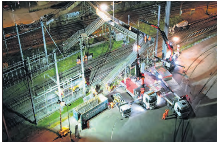
Der Abbau der Nordseite der alten Passerelle war Schwerstarbeit. Die Zugstrecke Basel-Frick wurde dafür gesperrt.
