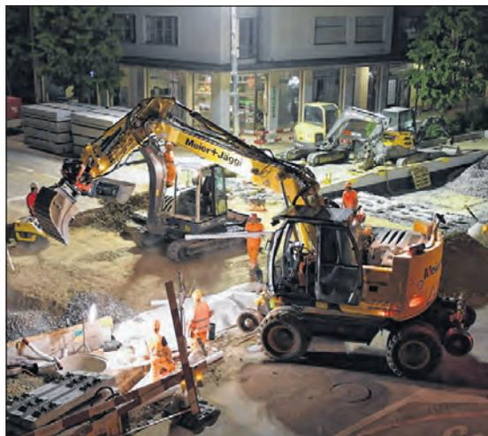
In der Nacht zum Samstag wird durchgearbeitet, bis am frühen Morgen die vorgefertigten Betonplatten mit Aussparungen für die Schienenstränge verlegt sind und versiegelt werden können.
