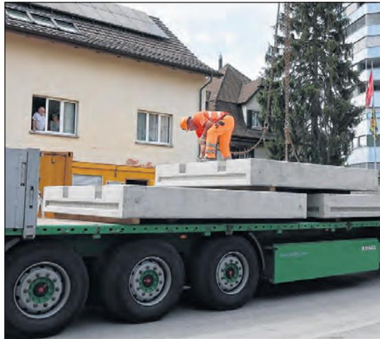
Die Betonelemente für den neuen Bahnübergang der Tramlinie 14 werden am Freitag angeliefert und mit einem Kran vom LKW gehoben. Parallel wird der ausgehobene alte Übergang neu verfüllt. Fotos Markus Portmann
