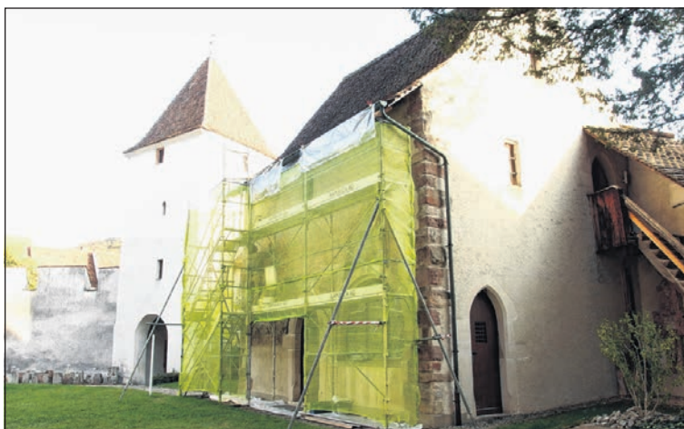
Ein schützendes Baugerüst hält den Fortschritt der Arbeiten am Beinhaus im Verborgen.
