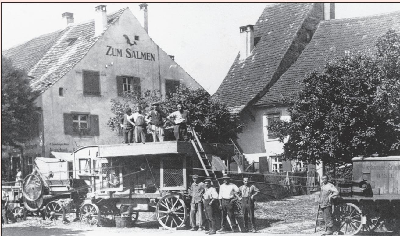
Stör-Drescher vor der Hauptstrasse 25: Gedrescht wurde hier für Max Frey-Oser. Reihenfolge der Maschinen: Motorwagen, Dreschmaschine, Strohpresse. Darum herum das Bedienungspersonal von mindestens 10 bis 12 Personen. Nach 1926.
