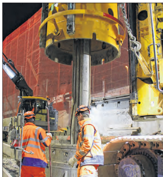
Für die Verankerung der Brückenpfeiler wurden über 40 Meter tiefe Bohrungen vorgenommen.
