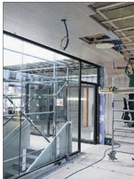
Gangbereich: Aufstockung mit Brandschutzverglasung der Treppe und Oberlicht.
