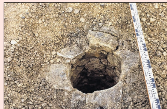
Gemauerter Lüftungsschacht, 1977.
