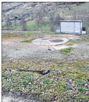
Eine beschädigte Kaverne in der Zinggibrunn gibt den Grünen Anlass, den Salzabbau mit Nachdruck zu verhindern (Symbolbild). Foto Archiv MA
