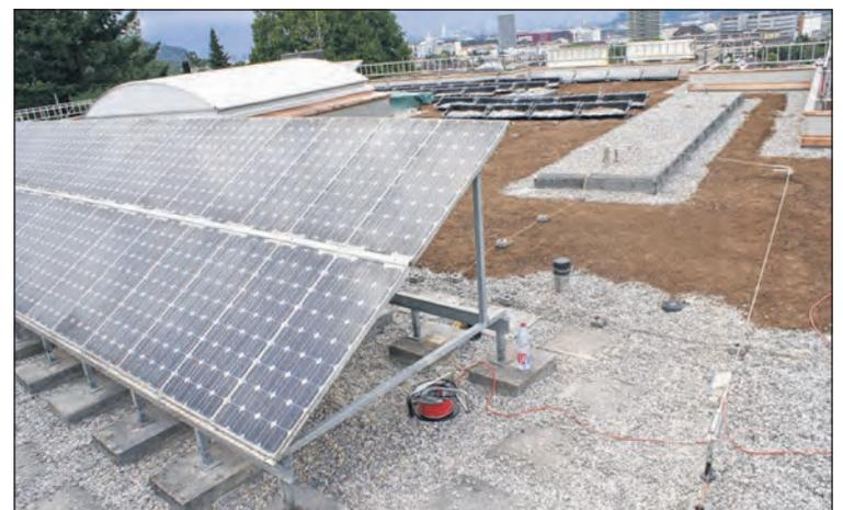
Die PV-Anlage auf dem Erlimattschulhaus ist auch nach 30 Jahren noch gut in Schuss. Die Anlage hat bis Ende 2023 ca. 390,323 MWh elektrische Energie erzeugt. Die moderneren Anlagen sind dabei günstiger, effektiver und leichter zu montieren. Fotos zVg
