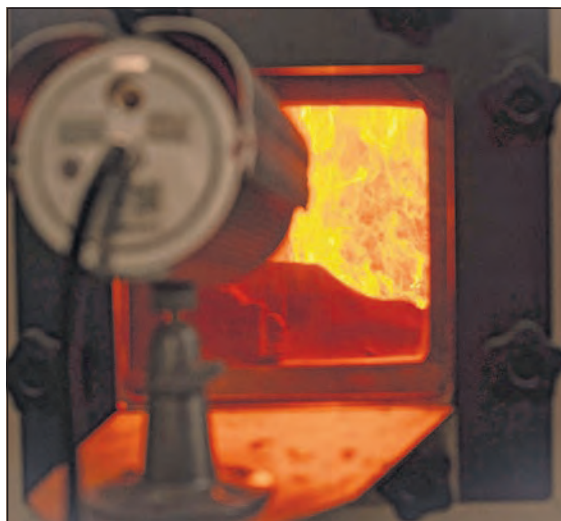
Das Feuer wird computergesteuert gefüttert und kann mittels der Kamera auch live beobachtet werden.
