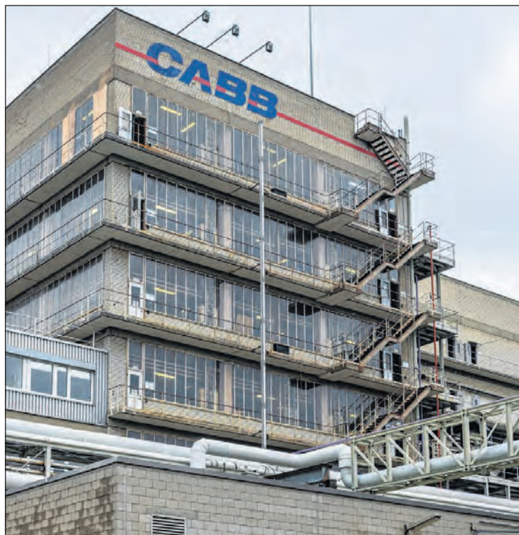
Im Erdgeschoss von Gebäude 308 trat Acetylchlorid aus. Die Feuerwehr hielt das Gas mit einer Wasserwand im Gebäude. Fotos David Renner
