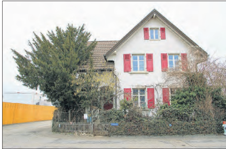
Das Grundstück ist strategisch nicht mehr von Bedeutung, das Haus stark sanierungsbedürftig. Der Einwohnerat stimmte dem Verkauf der Parzelle mit der Liegenschaft Lindenweg 1 daher zu. Foto Reto Wehrli
