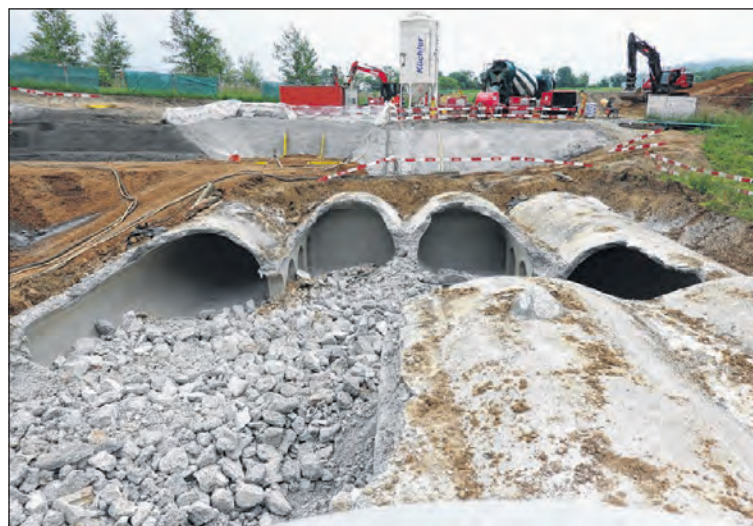
Die Bauzeit dauerte rund zwei Jahre. Während der ersten Bauphase wurden die ältesten beiden Kammern zurückgebaut.
