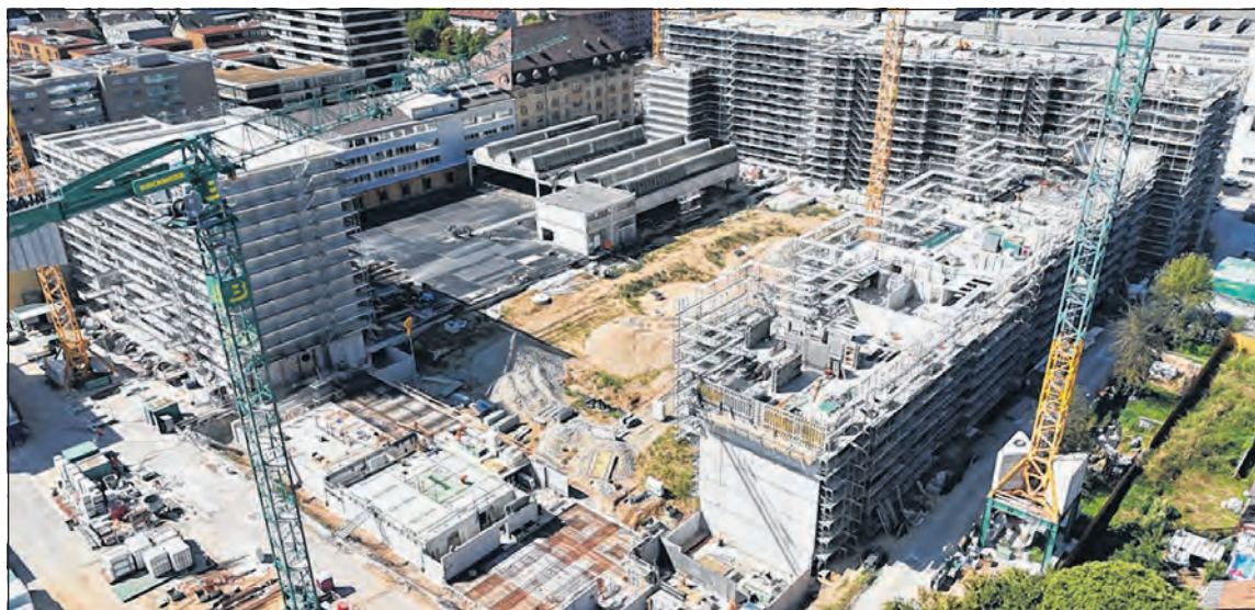
«Zentrale» nimmt eine grosse Etappe, die die sechs Bauräger feiern.
