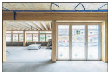
Die Tagesstruktur wird im Obergeschoss ihr Zuhause haben.
