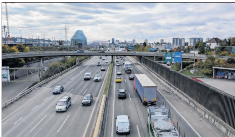
Das Nadelöhr der Nord-West-Schweiz: Der Rheintunnel soll die Kapazitätsengpässe an der neuralgischen Stelle beheben.
