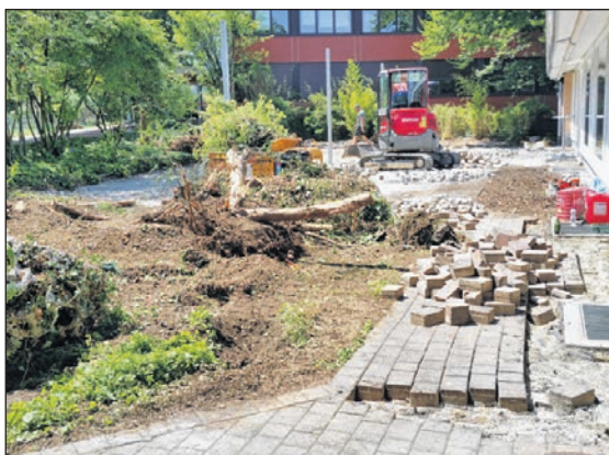
Innerhalb von sechs Wochen wurde die Gartenterrasse komplett neu gestaltet.
