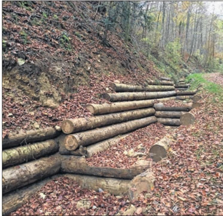
Im Flöschgraben soll mit solchen Konstruktionen Geschiebe durch starke Regenfälle verhindert werden.
