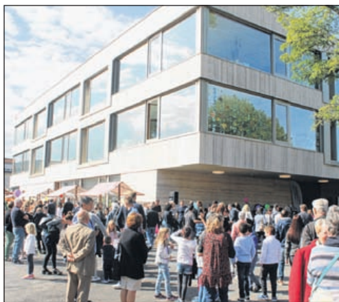
Feierlich wird das Primarschulhaus Gründen eingeweiht. Zahlreiche Interessierte werfen einen Blick hinter die Fassade des Neubaus.
