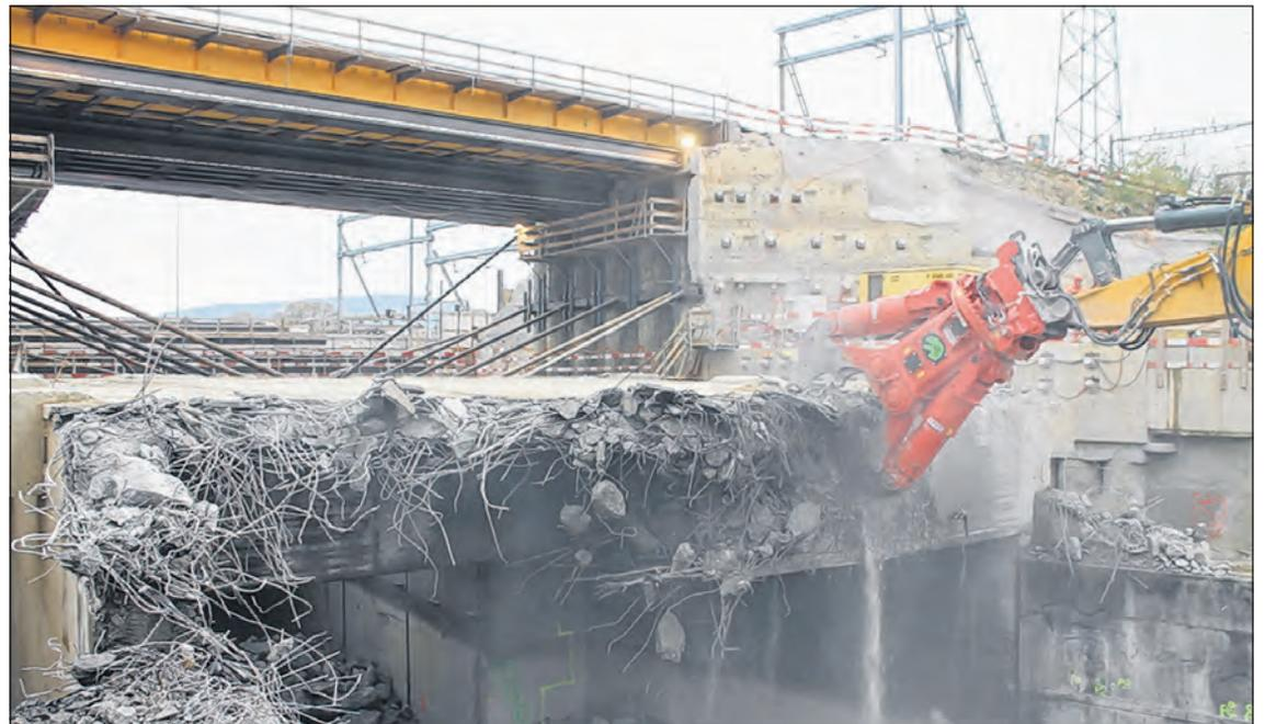
Ein gewaltiges Unterfangen: Innerhalb eines Wochenendes wurde mit Hilfe des europaweit grössten Rückbaubaggers «A-Rex» ein Grossteil des Hagnau-Tunnels abgerissen.
