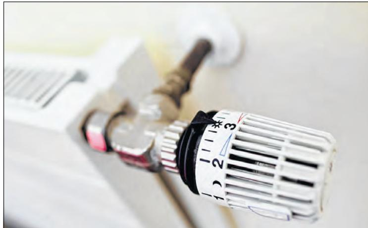
In der Regel entspricht die Position 3 (Sonne) einer Raumtemperatur von 20 Grad.
