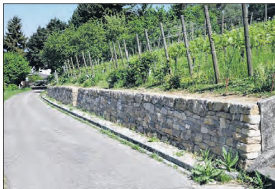
Die rissige und gerade Betonmauer (linkes Bild) aus dem Jahr 1934 wurde durch eine gschwungene Trockenmauer mit zwei Treppen ersetzt.
