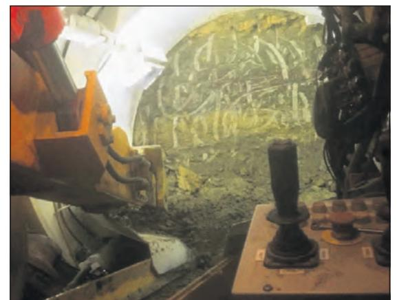
Sieben Meter unter der Erde wird lehmiger Untergrund abgetragen.
