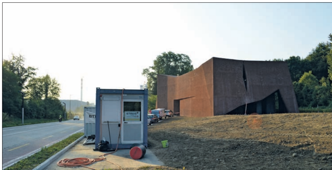
Noch werden an der Trinkwasseraufbereitungsanlage letzte Arbeiten verrichtet. Die Eröffnungsfeier ist für Mai 2017 geplant.
