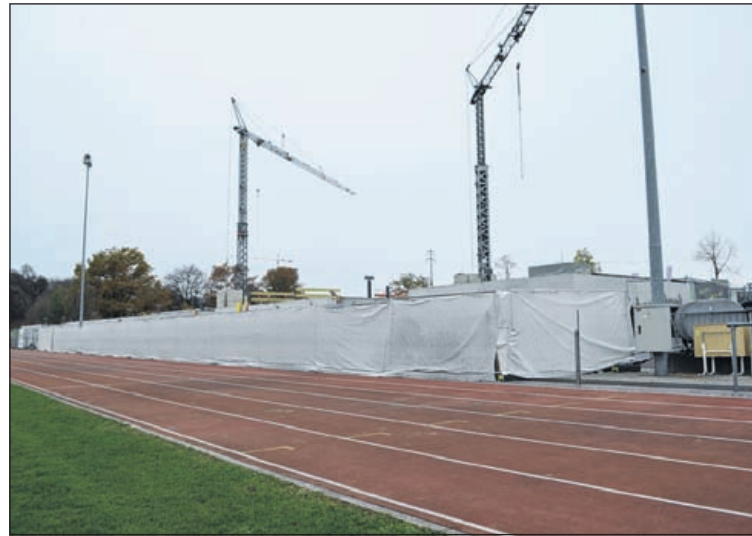
Die Arbeiten am neuen Infrastrukturgebäude auf den Sportanlagen Sandgruben gehören zum Prattler Investitionspaket. Foto Daniel Schaub
