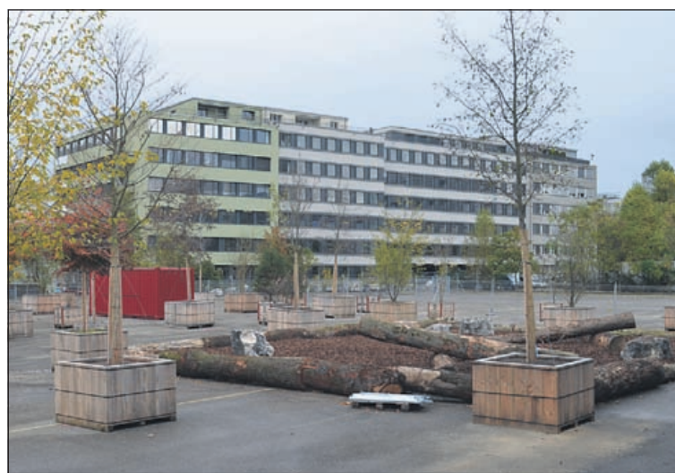
Ein Spielplatz im Innenhof lädt die Kleinsten auch bei winterlichen Temperaturen zum Herumtoben ein.
